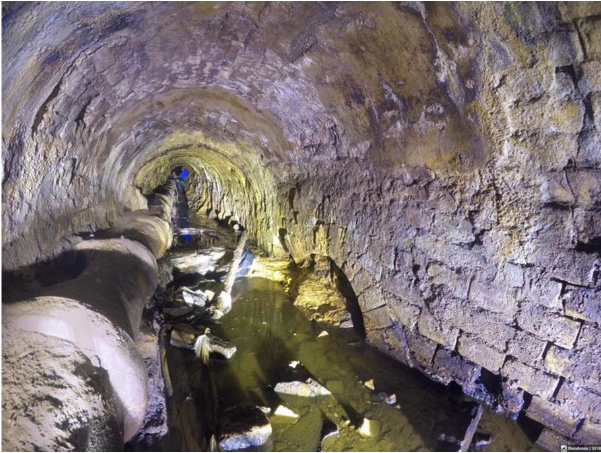
Галерея із водопроводною трубою
