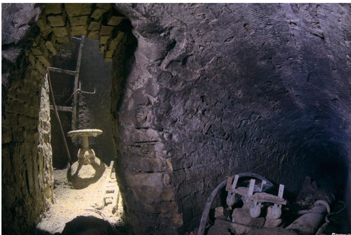
Тунель водопроводу в районі Зеленого театру
