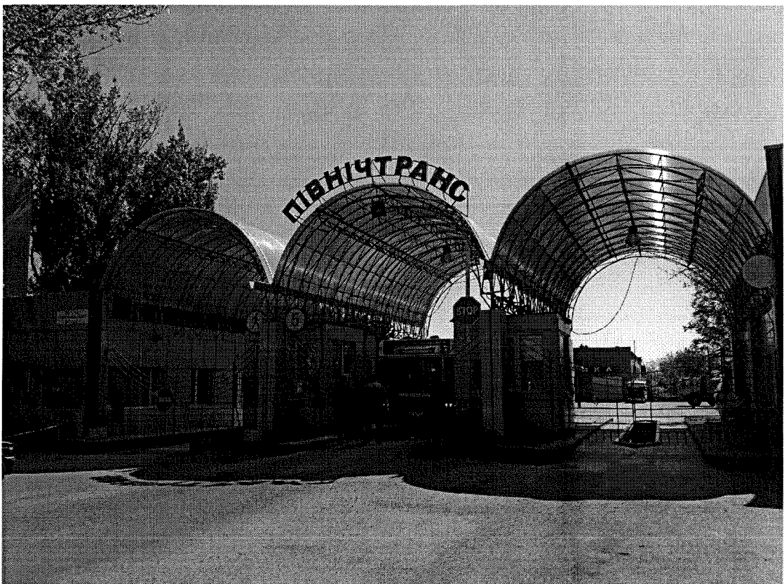
Фото 7.3 В'їзд на територію ПАТ «Північтранс», контрольно-технічний пункт з проїзною канавою для огляду транспортних засобів.
